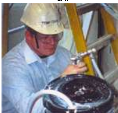
PARA ASEGURAR UNA CORRECTA APLICACIÓN, MANTENGA LA PISTOLA A UNOS 10 CM. DEL ENVASE TEMP-COAT®101
