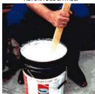
A MEDIDA QUE VA PULVERIZANDO, MANTENGA TEMP-COAT®101 MEZCLADO. USE UN PALO O UNA PALETA PLANA.
