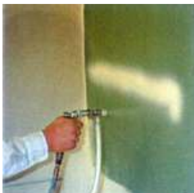
SOSTENER LA "QUIK GUN" A UNOS 35 CM. DE LA SUPERFICIE A RECUBRIR Y APLIQUE CON UN ANCHO DE 10-12 CM.
