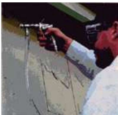
SOSTENIENDO LA PISTOLA CERCA DE LA SUPERFICIE APLICARÁ UN ANCHO MENOR *.
